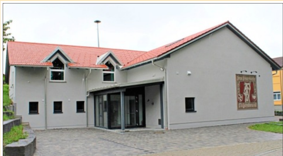
Das Dorfgemeindehaus hat durch den Umbau eine großartige Aufwertung erfahren. – Foto: J. Poth
